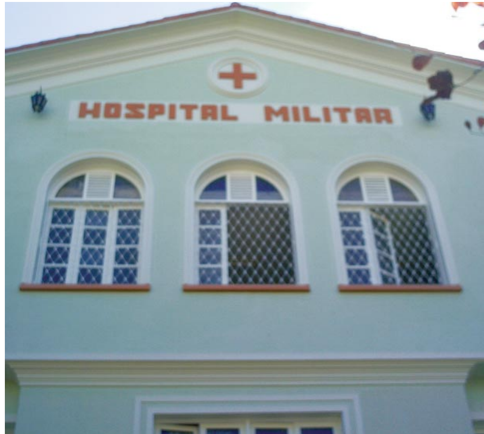
Fachada do prédio do HPM, que funciona desde a década de 70 mantendo qualidade no atendimento aos pacientes gravemente enfermos
